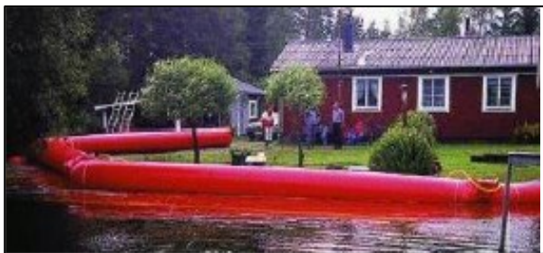
A sinistra: barriera riempita ad aria, a destra: barriera riempita ad acqua.
