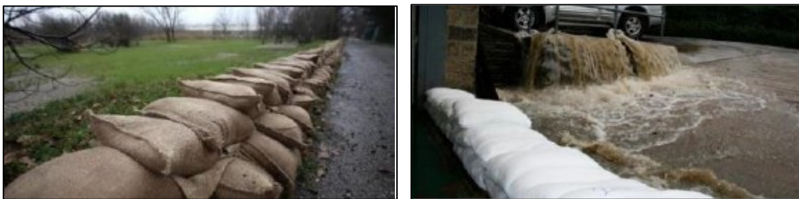
A sinistra: sacchi riempiti di sabbia, a destra: sacchi riempiti con materiale sintetico assorbente.
