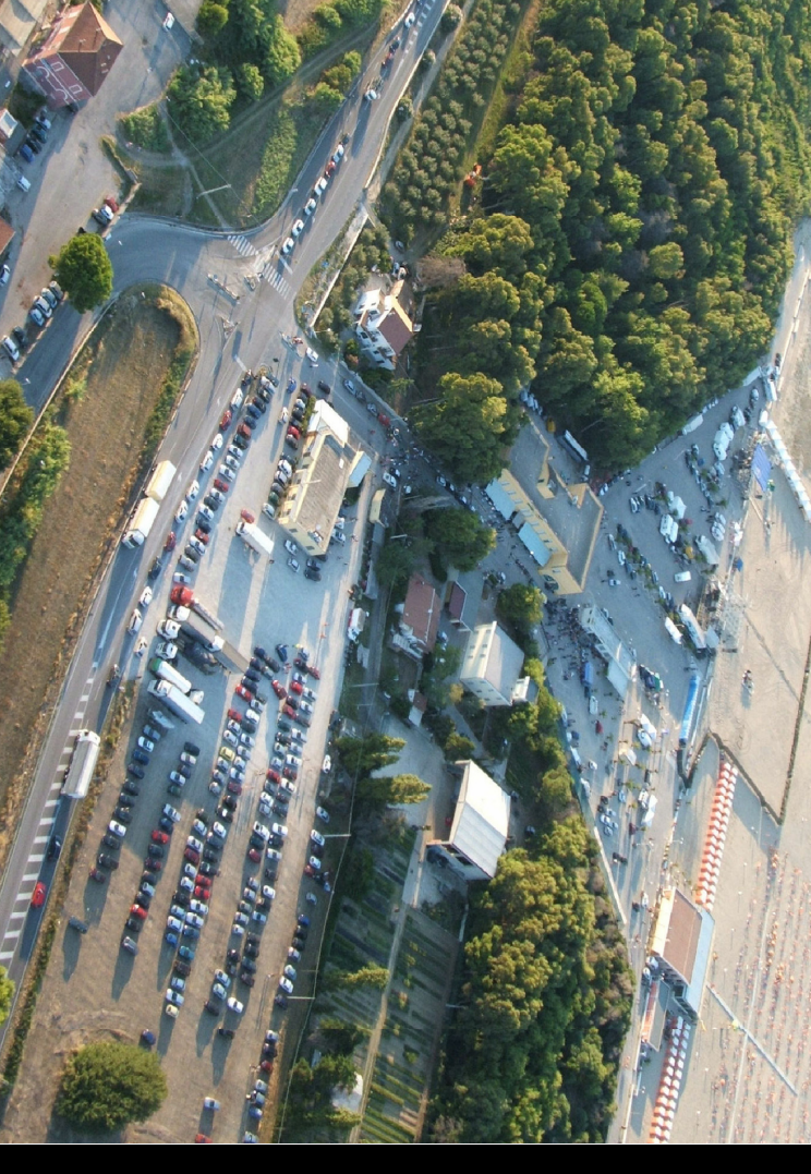
30 - (Ortofoto) - Area fore torrense "Trecchio" con fiammogrado campo di addezione ambientale e scoppio di osservazione su stagno in corso di realizzazione (Dall'opera CUE n° 20/04)
