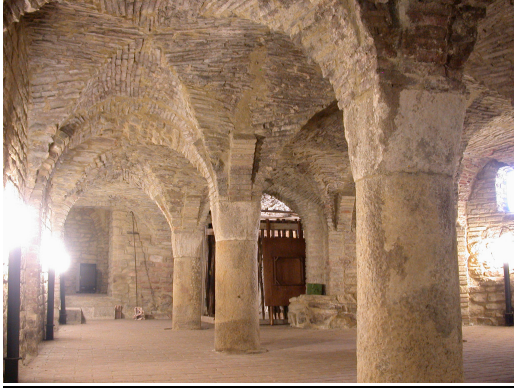
Cripta inferiore chiesa di S. Rocco
