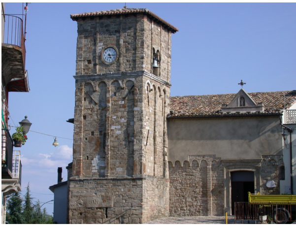
Chiesa di S. Rocco e torre campanaria
