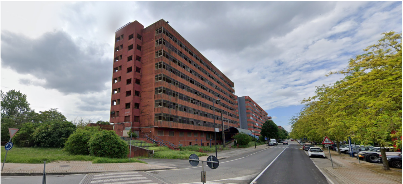
Figura 2 Vista dell'ex hotel Ripamonti 2 dalla rotonda di via dei Pini angolo via Roma
