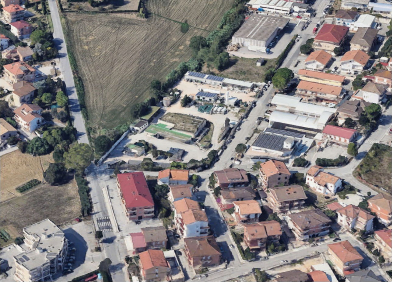
Figura 3 - Foto Panoramica dello stabilimento vista da est
