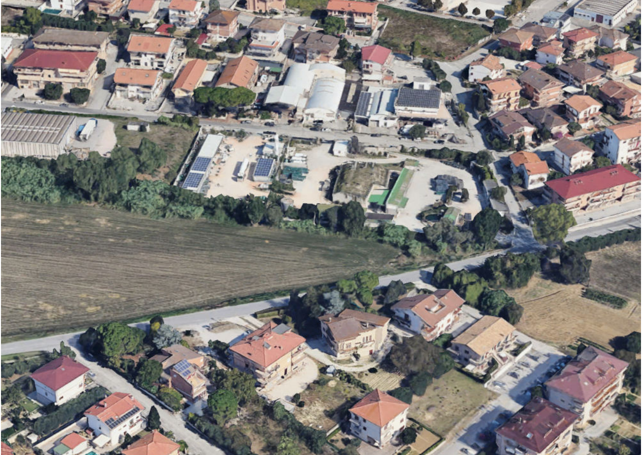
Figura 4 - Foto Panoramica dello stabilimento vista da sud
