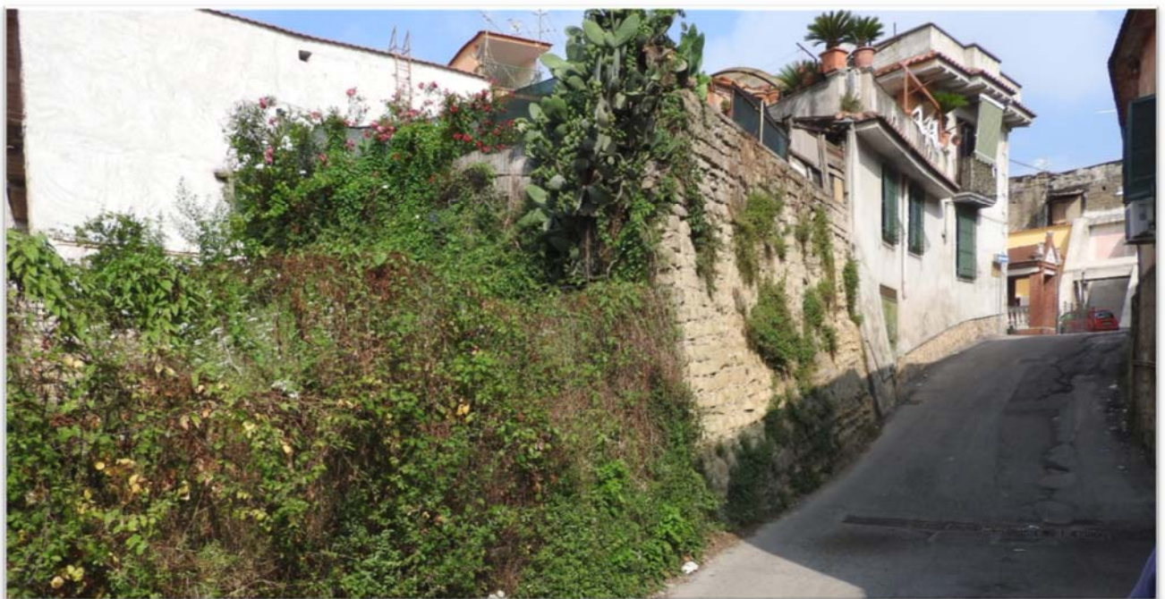
Figura 36: probabile imbocco a cavità sotterranea, da memoria storica di Franco Tesone
