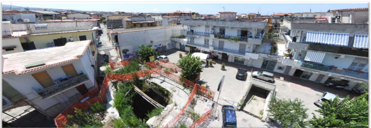
Figura 54: Sinkhole antropogenico di via de Gasperi
