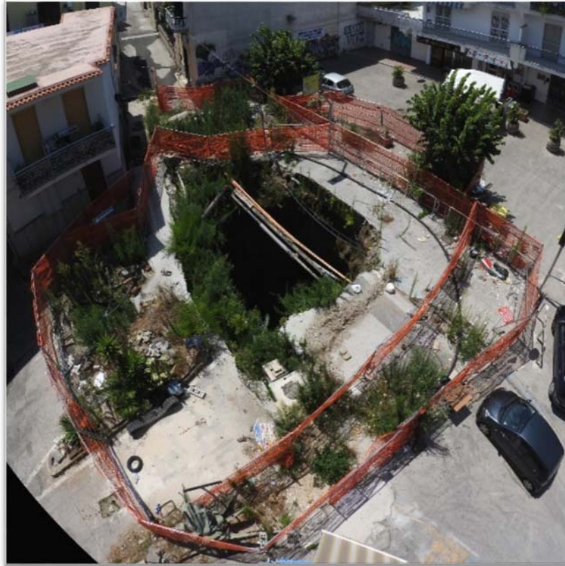
Figura 34: sinkholes antropogenico di via De Gasperi, foto del luglio 2016
