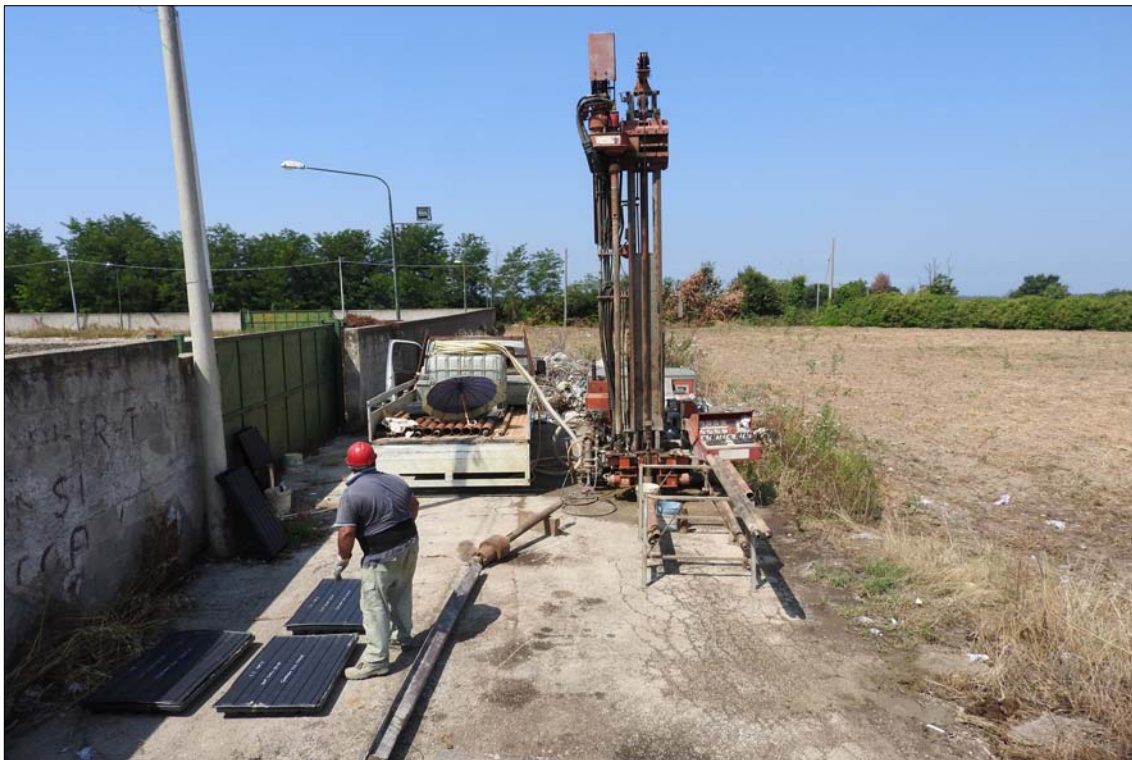
Postazione Sondaggio S2
