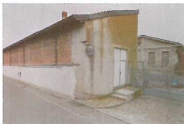
Fronte e accesso lungo via Cadorna
