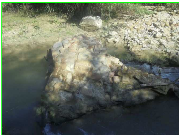
Figura 20 Settore 6, ruderi del ponte (Foto n. 31)
