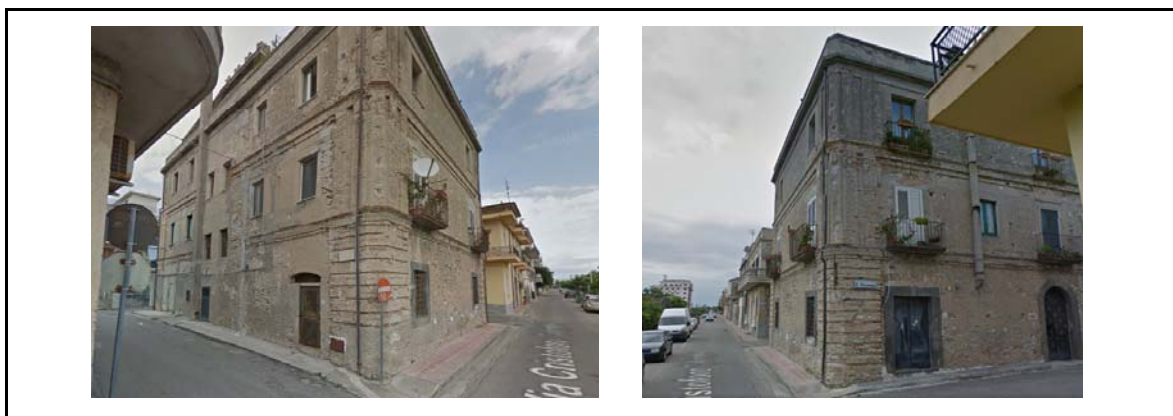
Fotografia del fronte e del contesto - prospetto su Via C. Colombo angolo Via Macri e Via Piromalli
