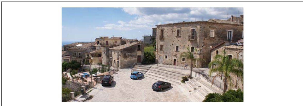
Fotografia del fronte e del contesto - Palazzo Colauti - prospetto posteriore con affaccio sull'anfiteatro a cielo aperto presso Piazza San Nicola
