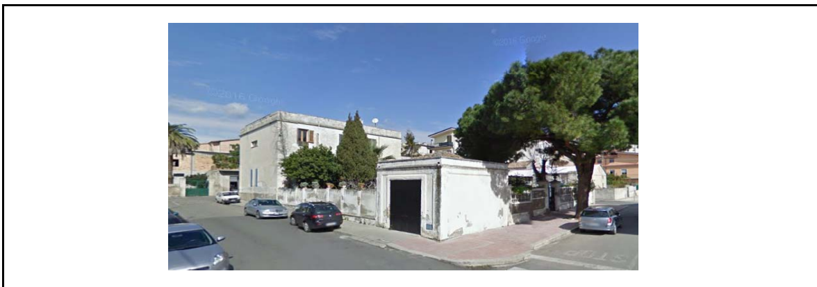
Fotografia del fronte e del contesto - prospetto su Via Carlo Pisacane
