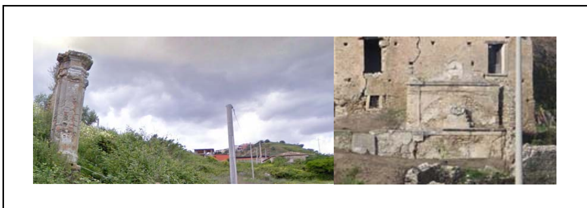
Fotografia del fronte e del contesto - prospetto su Via Peth
