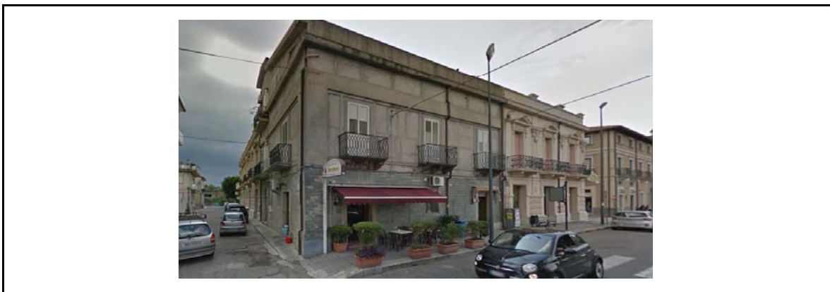
Fotografia del fronte e del contesto - prospetto su Via Giacomo Matteotti angolo con Via Roma
