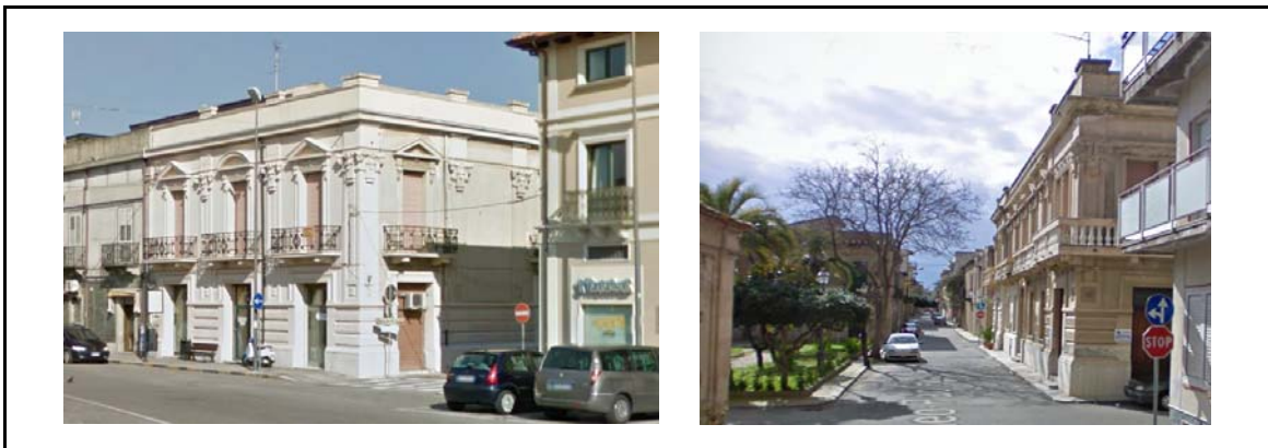
Fotografia del fronte e del contesto - prospetto su P.za Risorgimento e su Via Romeo angolo Via Roma
