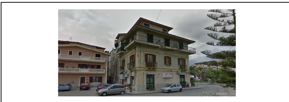
Fotografia del fronte e del contesto - prospetto su Piazza Stazione
