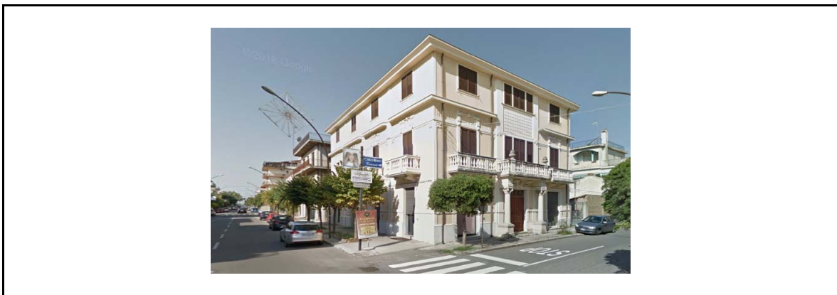
Fotografia del fronte e del contesto - prospetto su Corso Garibaldi - Via Fiume
