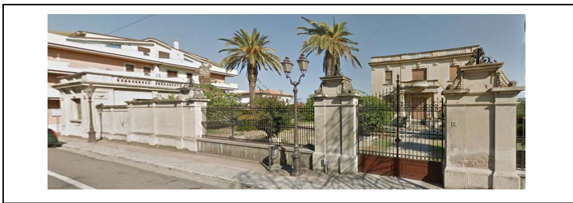
Fotografia del fronte e del contesto - prospetto su Corso della Repubblica
