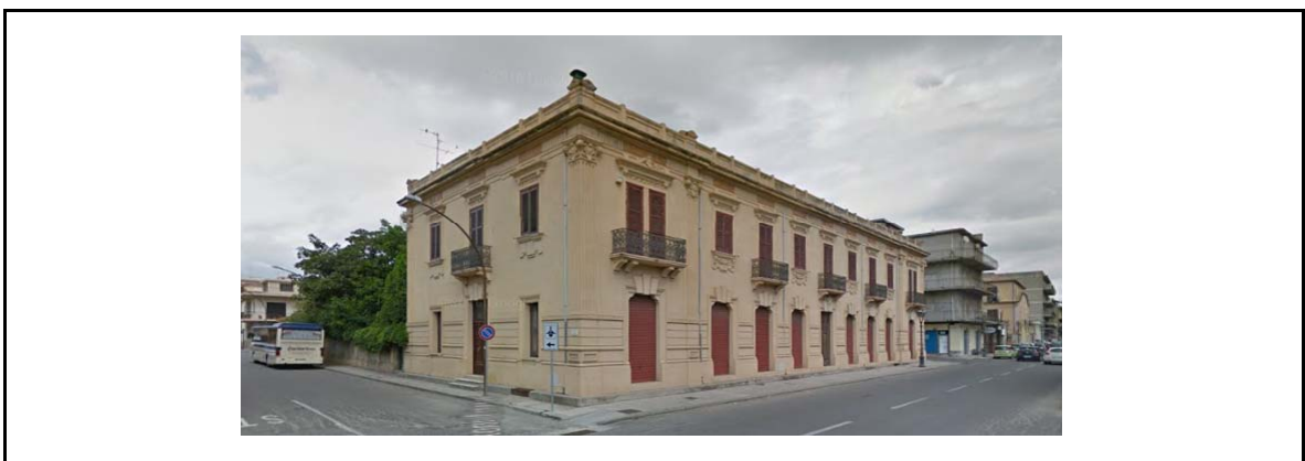
Fotografia del fronte e del contesto - prospetto su Corso Vittorio Emanuele
