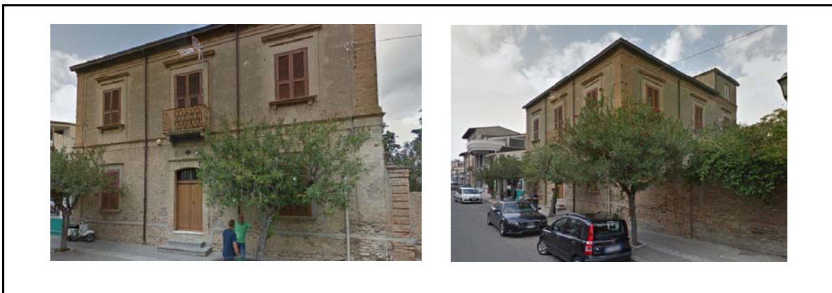
Fotografia del fronte e del contesto - prospetto su Via Giacomo Matteotti
