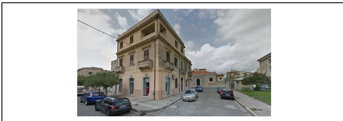
Fotografia del fronte e del contesto - prospetto su Via Giacomo Matteotti angolo Piazza delle Palme
