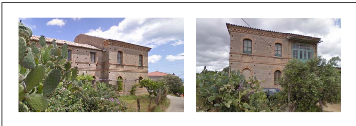
Fotografia del fronte e del contesto - prospetto su Via Trigoni
