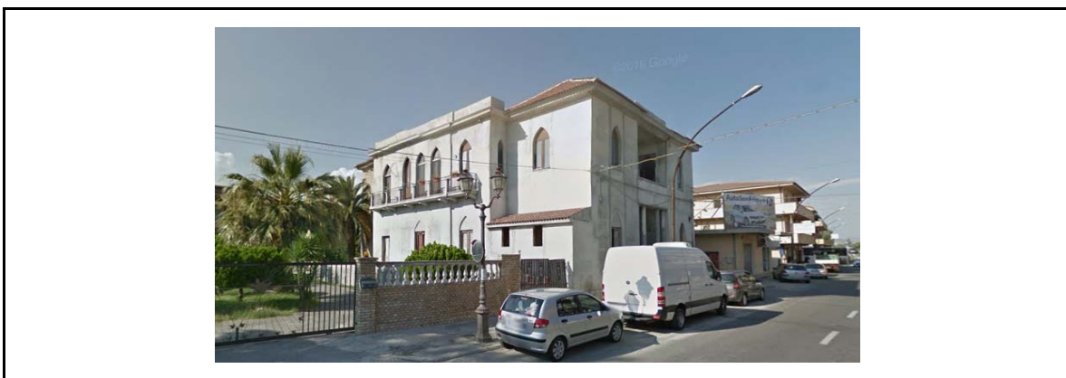
Fotografia del fronte e del contesto - prospetto su Via Enrico Fermi
