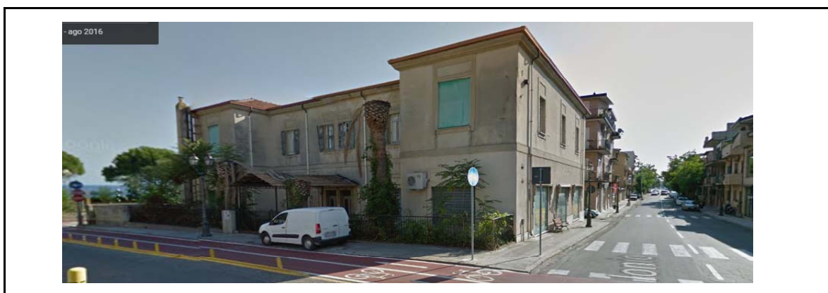
Fotografia del fronte e del contesto - prospetto sul Torrente Garino
