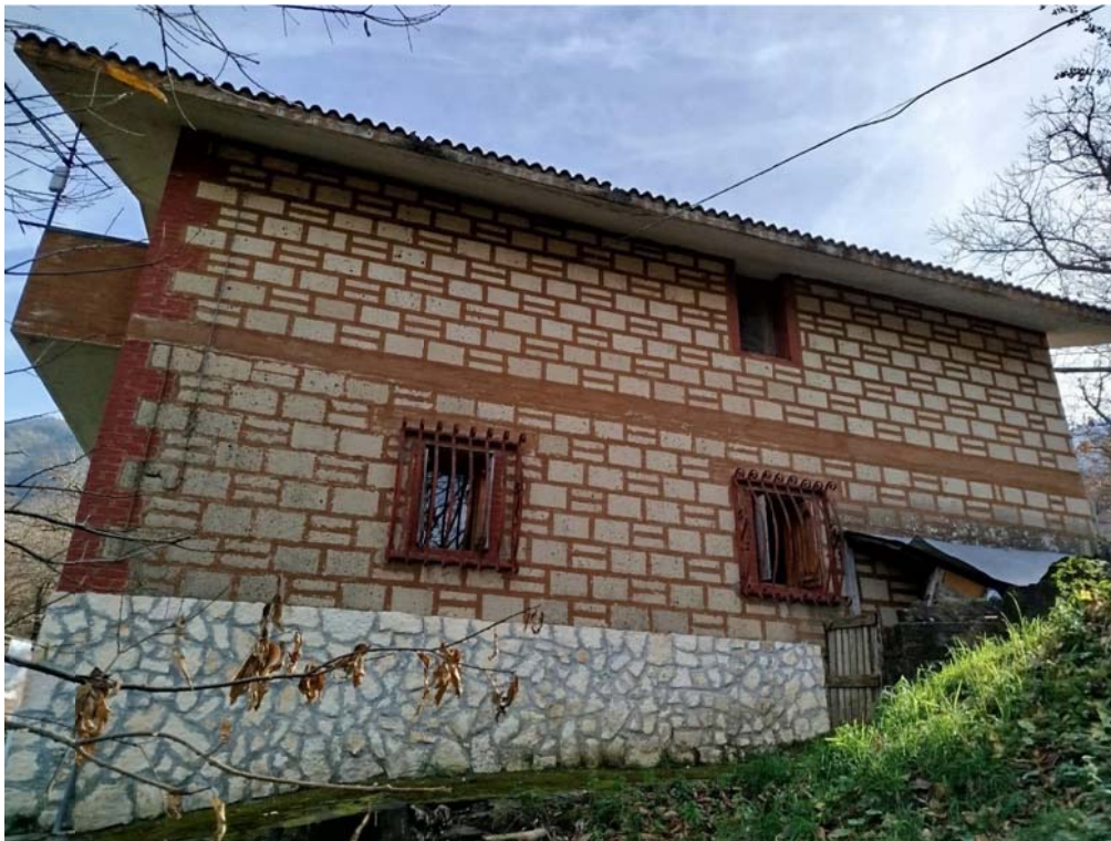
PROSPETTO LATERALE (SUD-OVEST)
