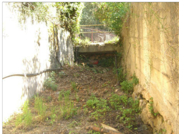
Foto 4 ambito Valle delle Anze - tratto a valle di località Pozzol
