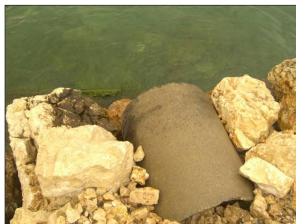
Foto 4 ambito Valle delle Prandine - particolare della condotta in cemento che «sfocia» nel Lago
