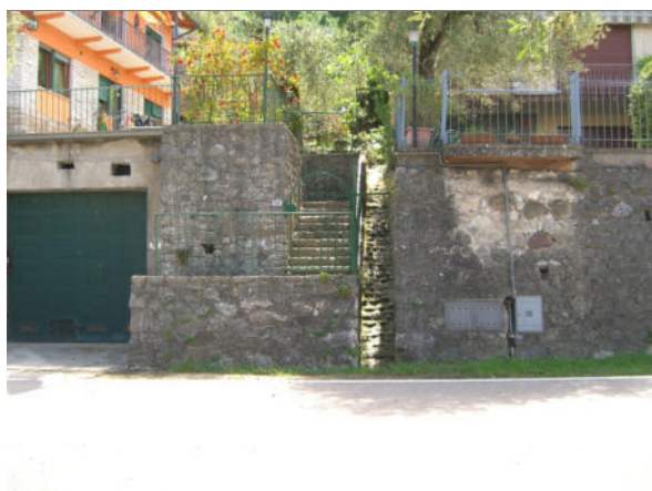
Foto 3 ambito Valle Bigarana - tratto a monte di Via Gardesana
