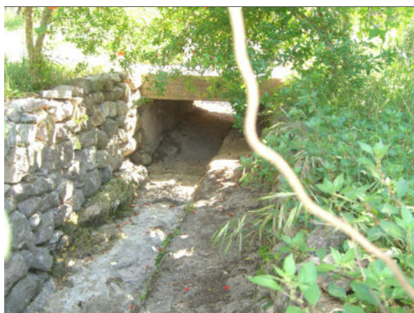
Foto 1 ambito Valle Buraga - tratto a monte di Via Rossini
