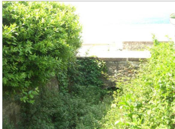
Foto 4 ambito Valle Fraga - attraversamento di Via Gardesana vista da est
