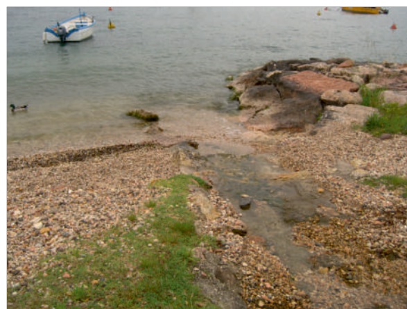
Foto ambito Valle di San Faustino - tratto di attraversamento di Via Gardesana - segni di processi di attivazione in atto
