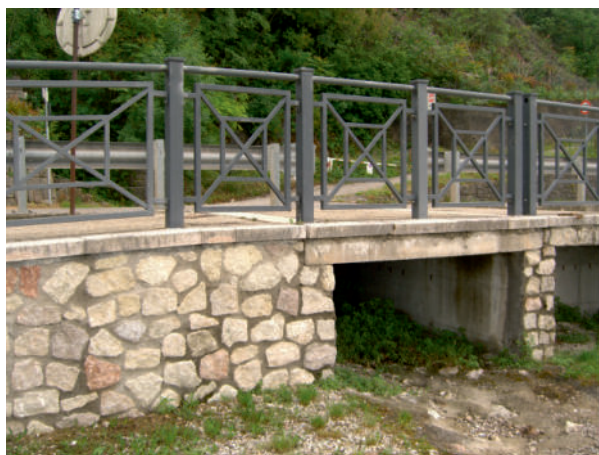
Foto ambito Valle di Pi NORD - tratto di attraversamento di Via Gardesana
