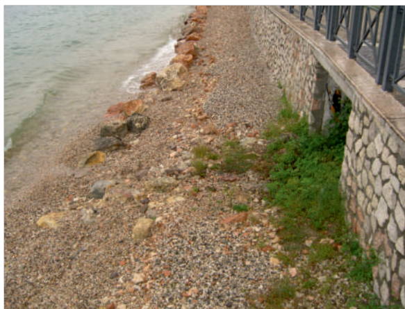
Foto ambito Valle della Formighetta - tratto di attraversamento di Via Gardesana
