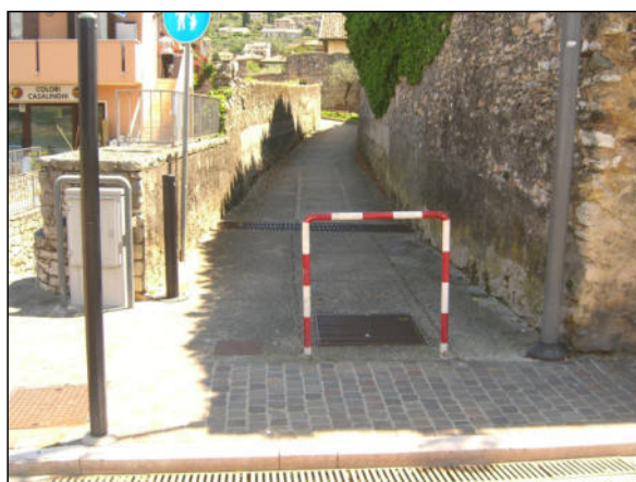
Foto 5 ambito Valle del Cop - tratto a monte di Via Gardesana (tratto pedonale)
