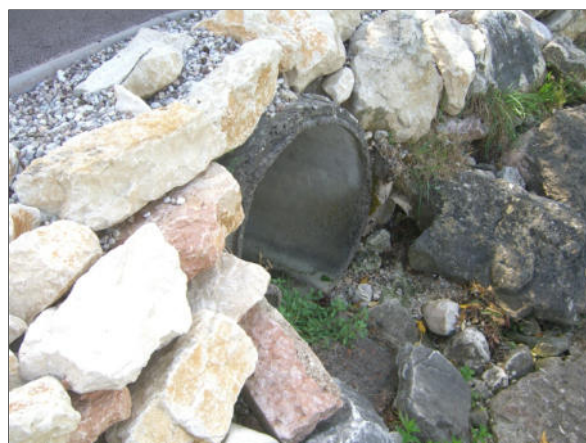
Foto 4 ambito foce Valle Bigarana- tratto a valle di Via Gardesana vista da nord
