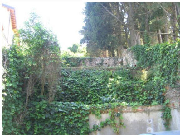
Foto 3 ambito Valle Buraga - tratto a monte di Via Mazzini
