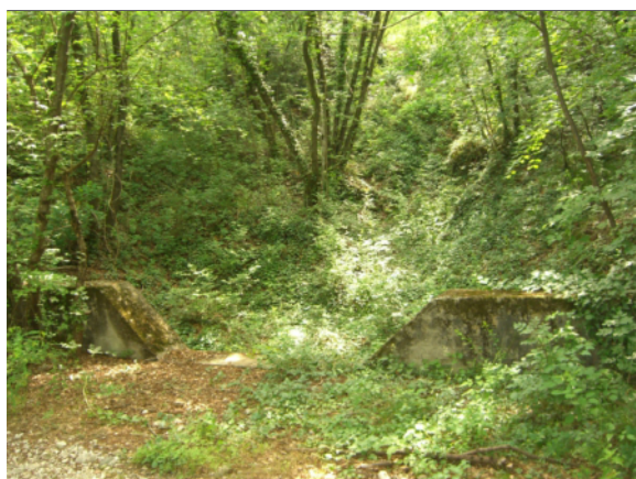
Foto 1 ambito Valle delle Camible - tratto a monte del sentiero a nord di località Spighetta
