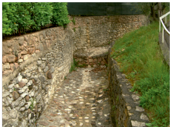
Foto ambito Valle dei Canevini - particolare dell'arginatura artificiale a monte di Via Gardesana
