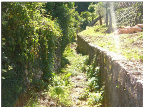
Foto 1 ambito Valle Rossone - tratto a monte di Via Mazzini
