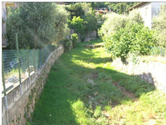
Foto 3 ambito Valle Valdana - tratto a monte di Via Gardesana
