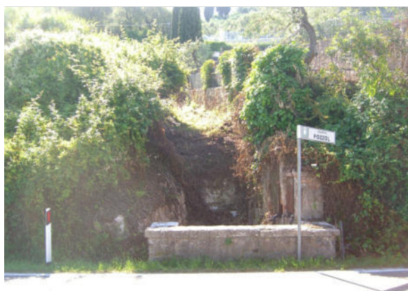
Foto 5 ambito Valle delle Anze - tratto a monte di Via Gardesana
