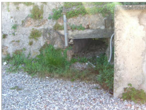
Foto 5 ambito foce Valle Polla - tratto a valle di Via Gardesana vista da ovest
