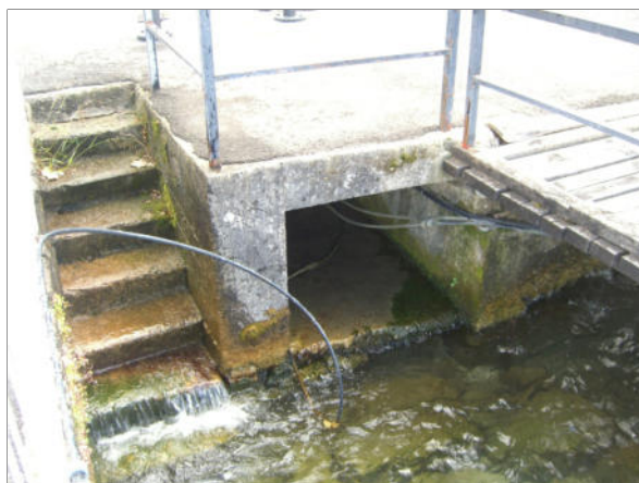
Foto 5 ambito foce Valle Creazza - tratto a valle di Via Gardesana vista da nord-ovest
