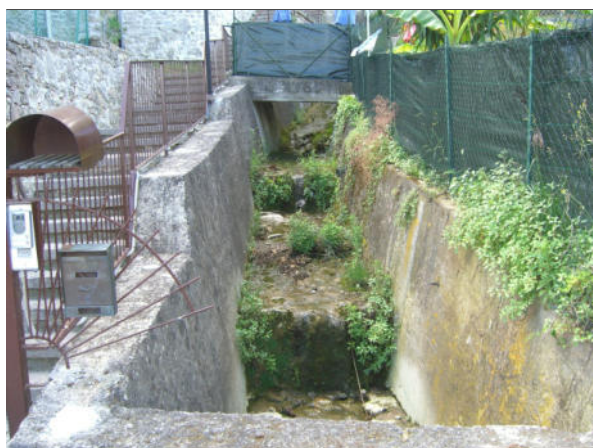
Foto 1 ambito Valle Creazza - tratto a monte di Via per Ca' Tronconi
