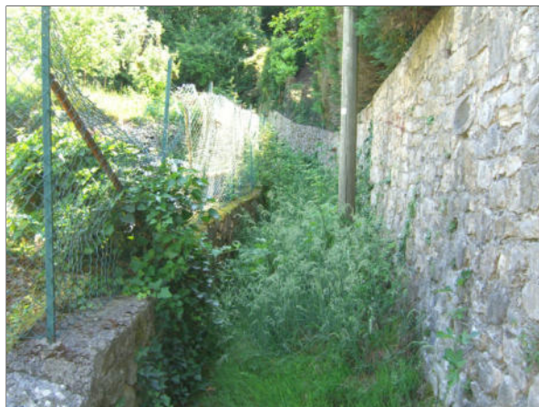
Foto ambito Valle di Castel Ronco NORD - tratto a monte di Via Rossone - tratto arginato con opere in muratura
