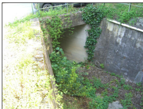
Foto 2 ambito Valle Coraca - tratto attraversamento Via Mazzini
