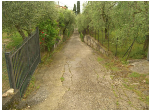
Foto 4 ambito Valle Quaradella - tratto intubato in corrispondenza di Via San Faustino
