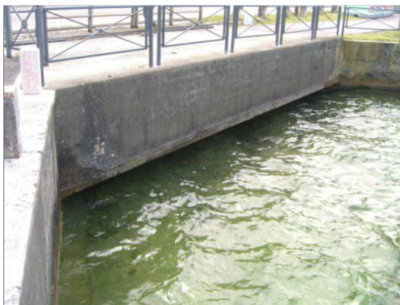
Foto 6 ambito foce Valle Fontana - tratto a valle di Via Gardesana vista da nord-ovest
