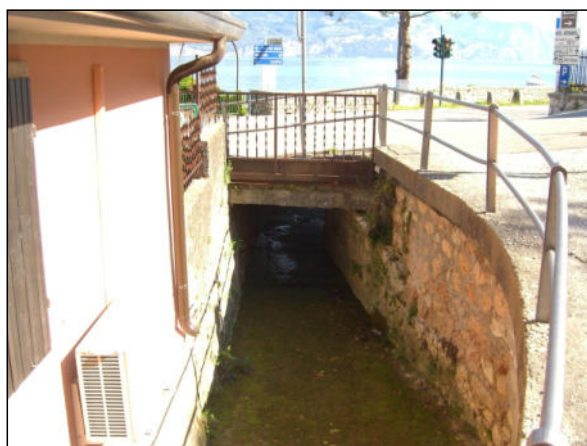
Foto 8 ambito Valle dello Zocco - attraversamento di Via Gardesana
