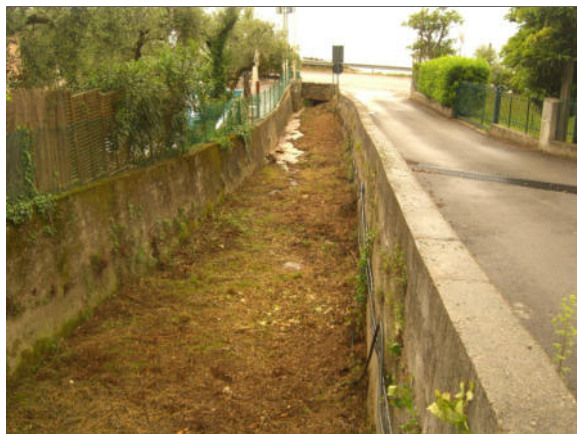
Foto 3 ambito Valle Storta - tratto a monte di Via Gardesana
