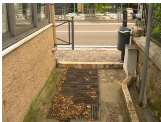
Foto 6 ambito Valle Santa Croce - tratto a valle di Via Gardesana (tratto pedonale)
