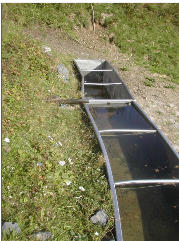
Immagine 6: vasche in acciaio inox da sostituire con vasche in acciaio zincato
