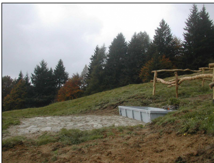
Immagine 9: esempio di vasca in acciaio zincato con opportuni rinforzi trasversali e sul bordo. Anteriormente acciottolato sul piano di calpestio degli animali - Oltressenda Alta, ottobre 2014
