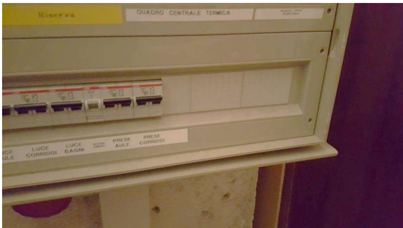
Fotografia 3 – installazione di interruttore di protezione c/o quadro elettrico esistente
