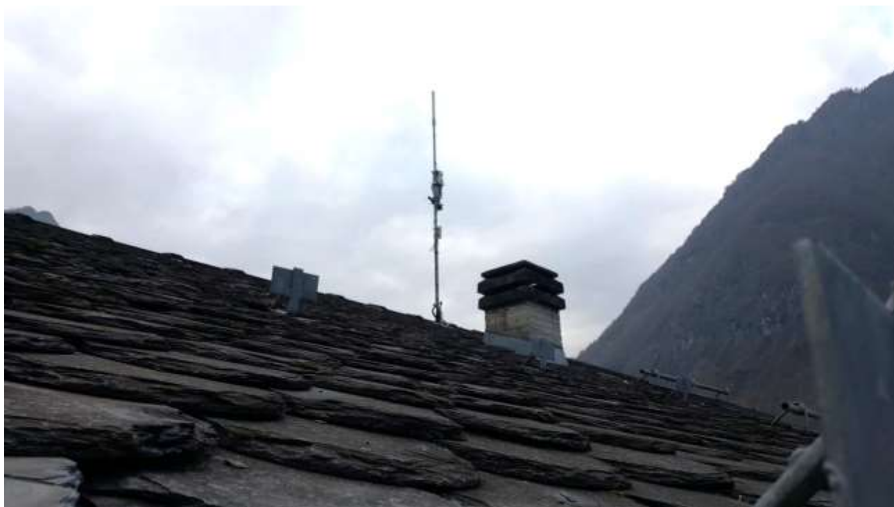
Fotografia 2 – installazione di antenna settoriale su asta esistente
