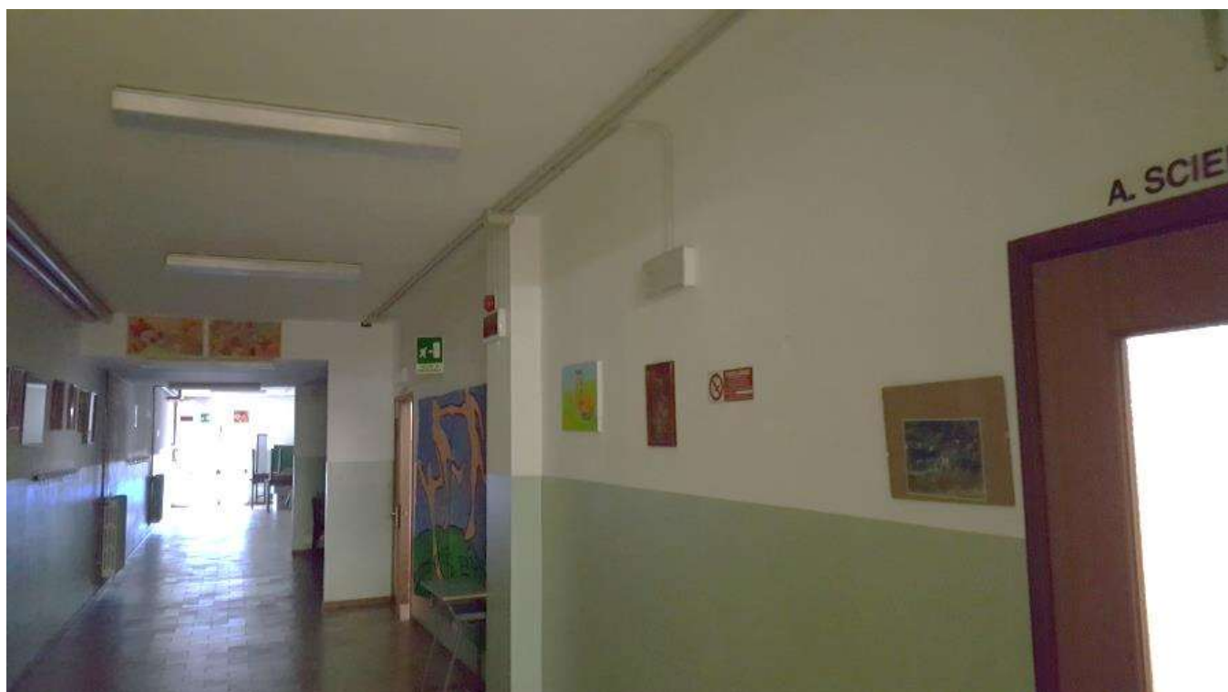
Fotografia 4 – posa di tubazione esterna lungo il corridoio per alimentazione presidio di videosorveglianza
