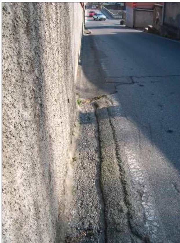
FIG. 125 Canaletta di scolo acque ripristinata a bordo muro rifatto
