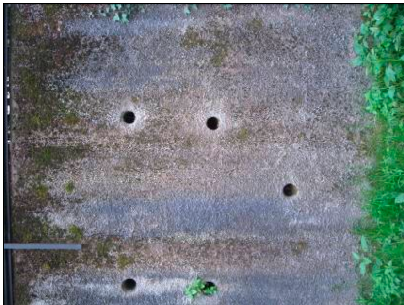
FIG. 119 Tubi di drenaggio lungo i muri di confine su Via Fontanelle
