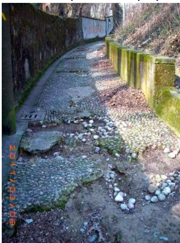
FIG.97 Particolate strada in erosione
