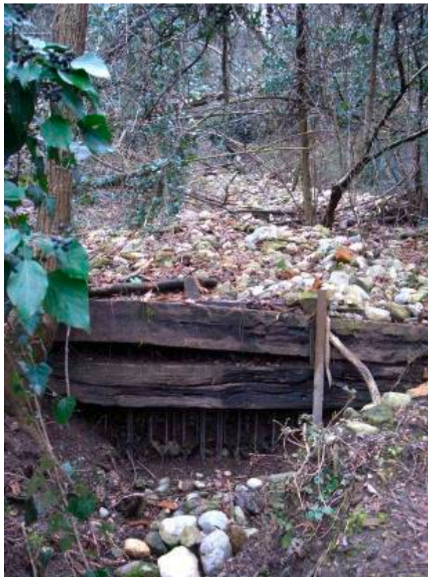
FIG.63 Briglia in legno rudimentale con Colata di materiale detritico
