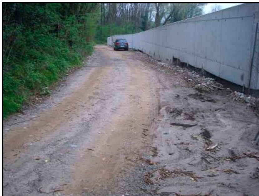
FIG. 121 Panoramica prolungamento Via Fontanelle adiacente area cimiteriale in ampliamento– Si osserva scarpata di monte che drena le acque provenienti dalla zona residenziale con fenomeni di allagamento
