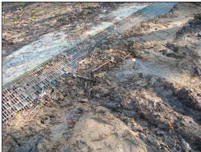
FIG. 107 Griglia per captazione corso d'acqua sovralluvionata
