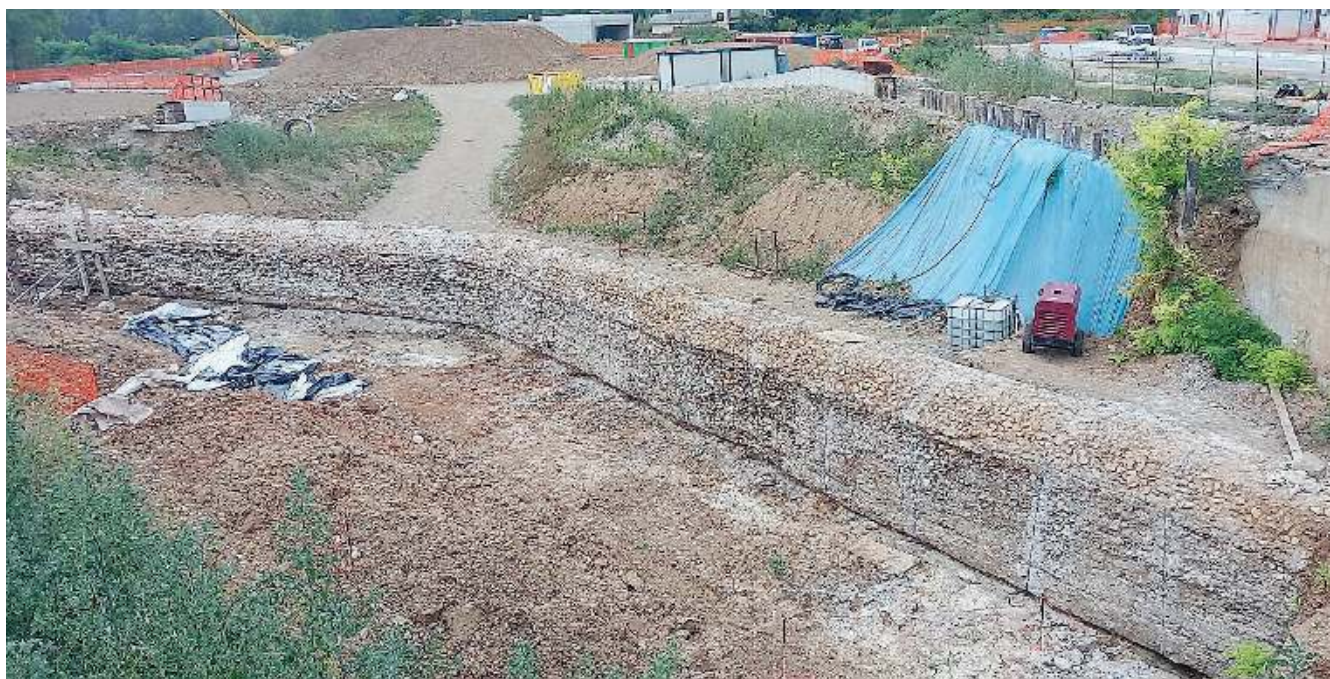
A Codolazza. Il tratto di acquedotto romano riemerso nel cantiere al confine tra Villa Carcina e Concesio
