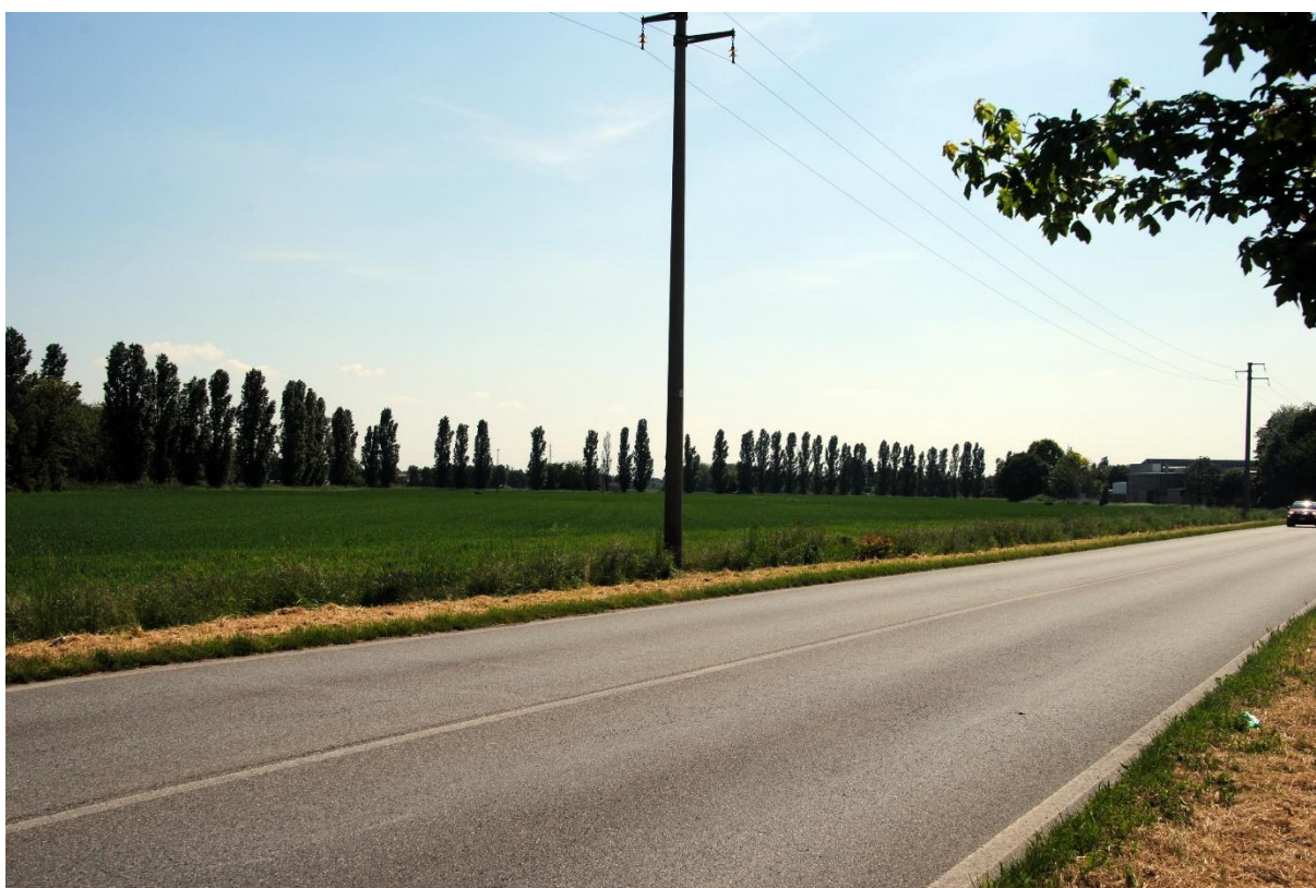
10. Veduta da Via Bolzano verso est
