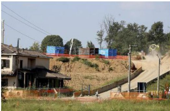
La denuncia degli attivisti: «I primi scavi stanno già causando gravi danni»
