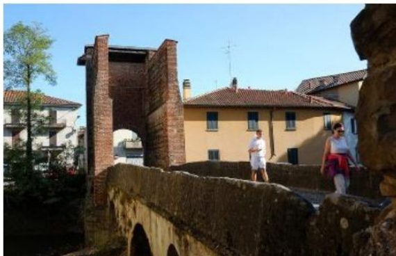
Il piano di manutenzione straordinaria del Ponte di San Rocco è pronto
